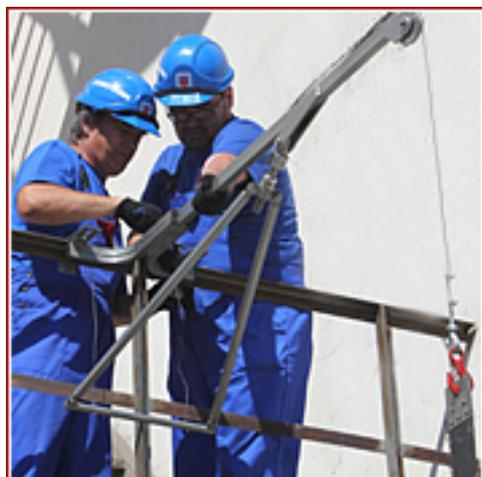
Кроме того, наружные пожарные лестницы и ограждения на крышах зданий не менее 1 раза в год должны проходить визуальную проверку целостности конструкции. В случае обнаружения нарушений целостности конструкции производится их восстановление (ремонт) с последующей проверкой на прочность.
